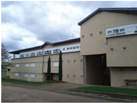
Vues extérieures du bâtiment
