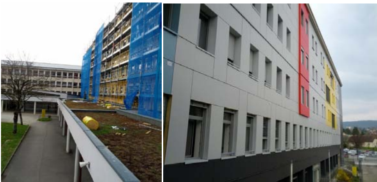
Partie de l'internat en rénovation Partie rénovée de l'internat
